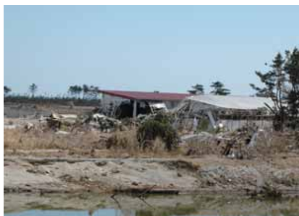
牛橋樋門周辺 (2011.3.28)
