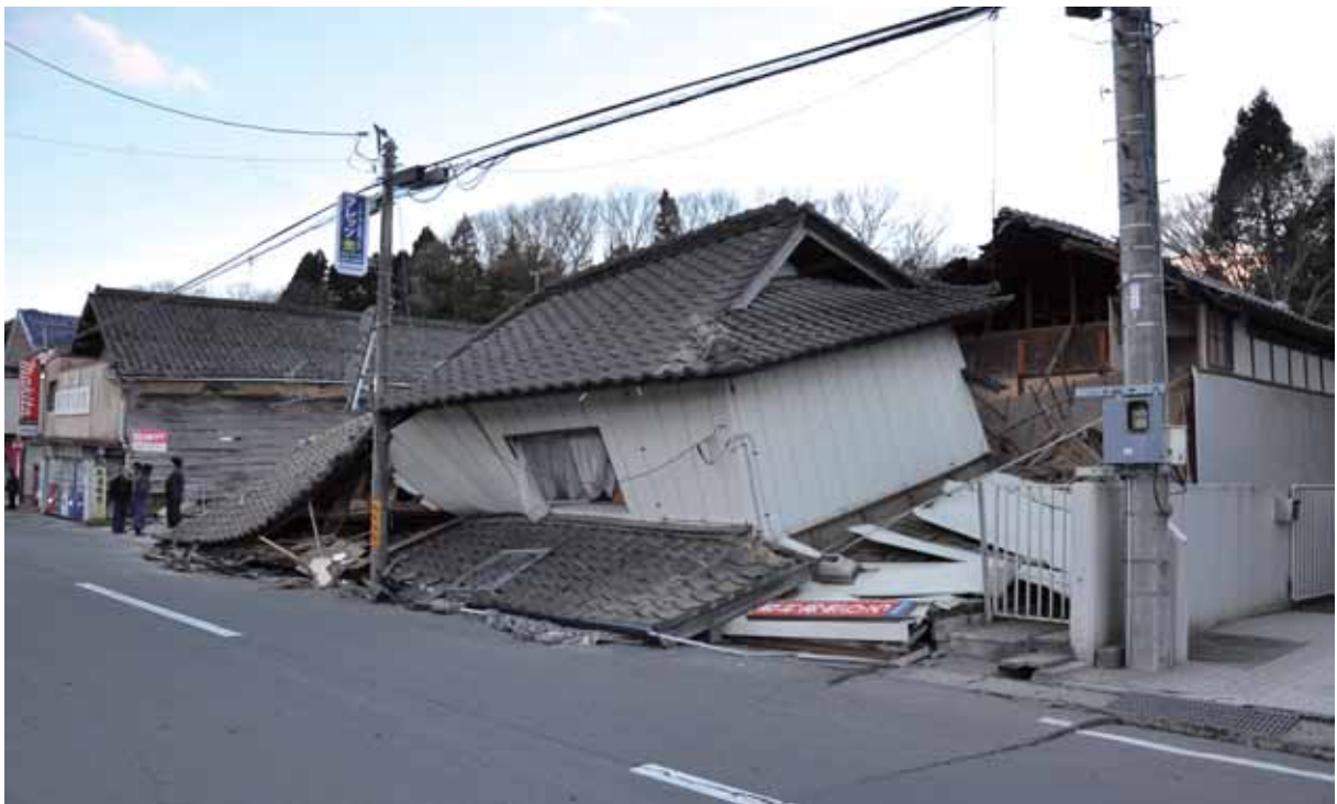
激しい揺れによって倒壊した家屋（山下地区）
