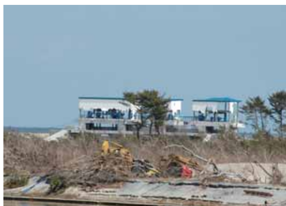
牛橋樋門周辺 (2011.3.28)
