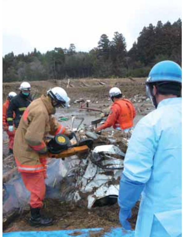
車両を解体しながら捜索を行う様子
