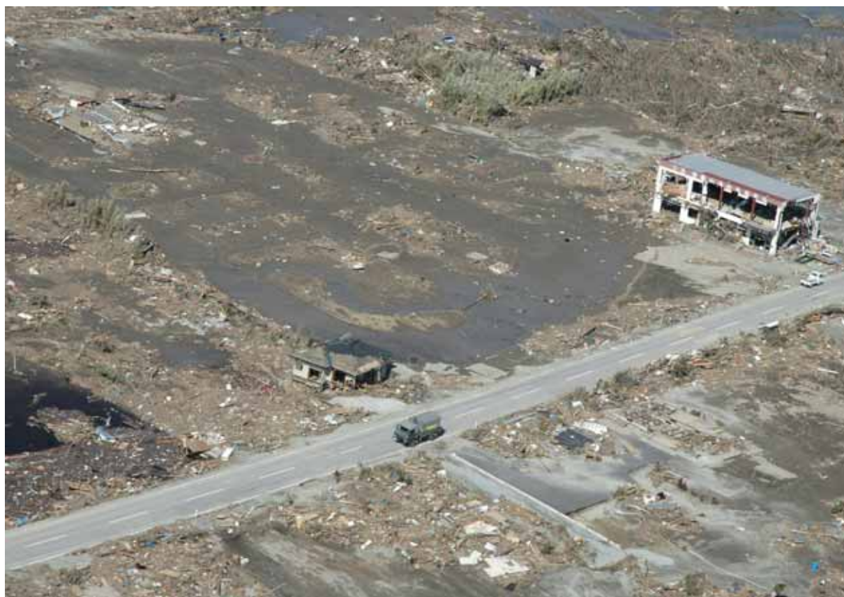
中浜・常磐自動車学校付近 (2011.3.19)
