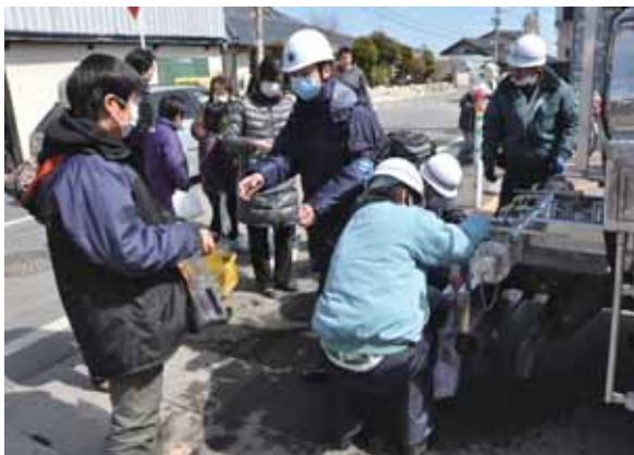
静岡県掛川市 (給水)
