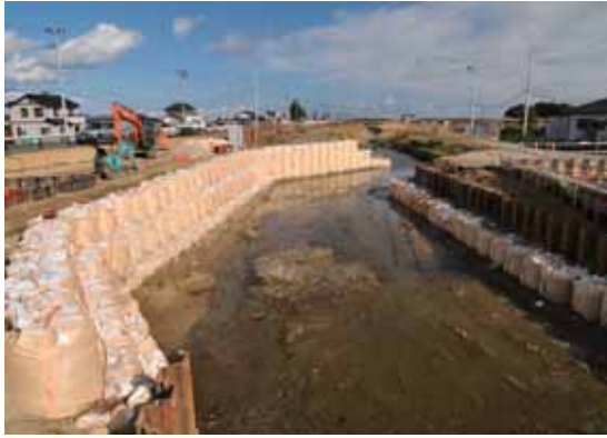
河川の復旧工事の様子
