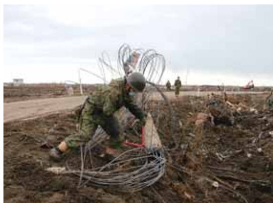
手作業で電柱の撤去を行なう様子
