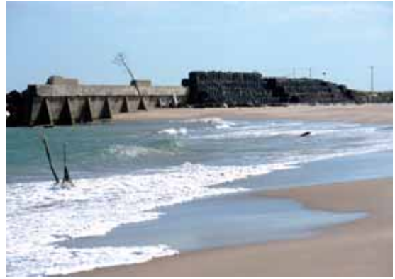
防潮堤の復旧の様子
