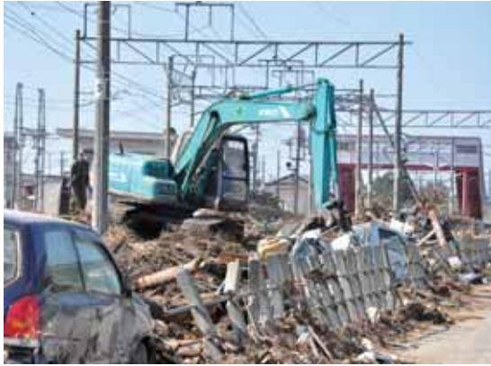
線路沿いの撤去作業を行う様子
