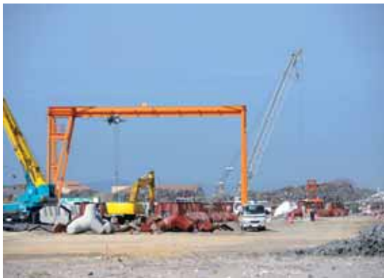
防潮堤の復旧の様子
