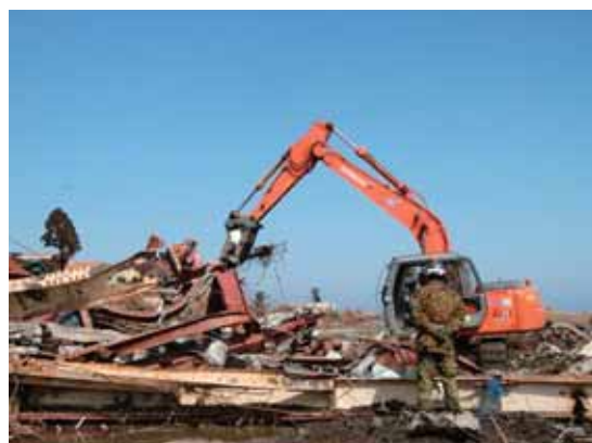
重機を使って撤去作業を行う様子
