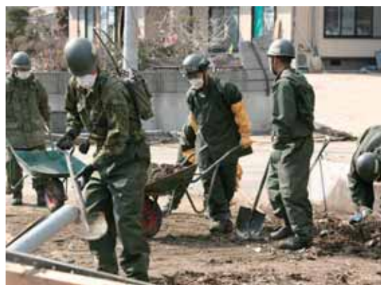
細かいがれきも丁寧に撤去していく
