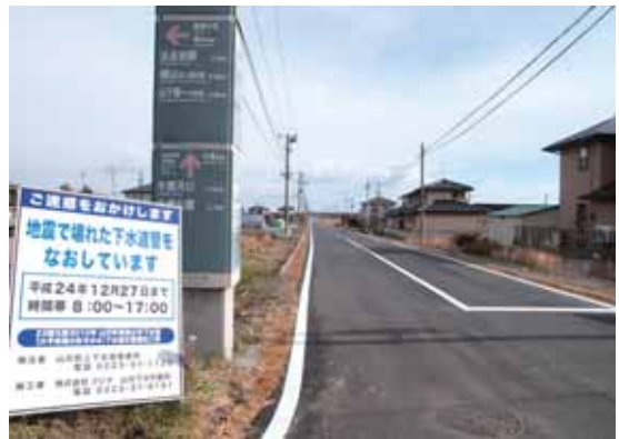
復旧した道路
