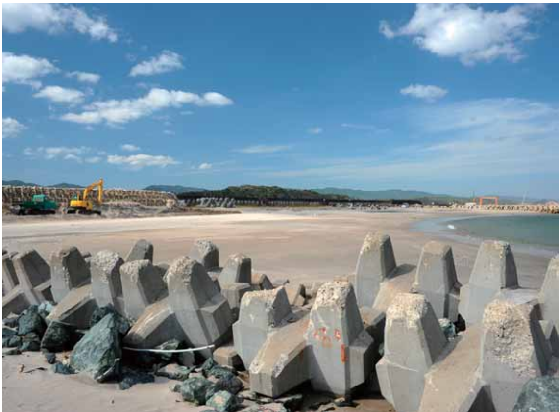
海岸の復旧の様子
