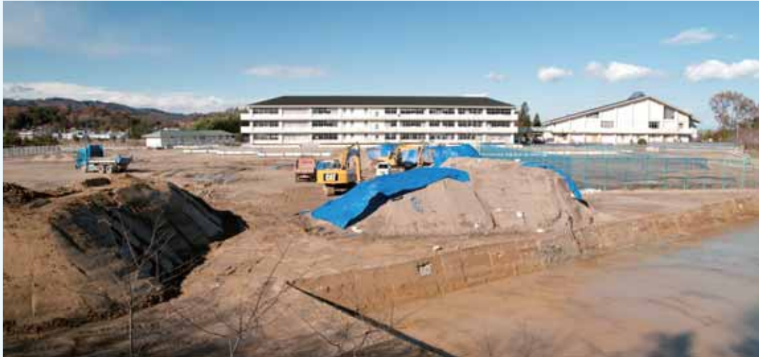
除染作業中の坂元中学校グラウンド (24.12.6)
