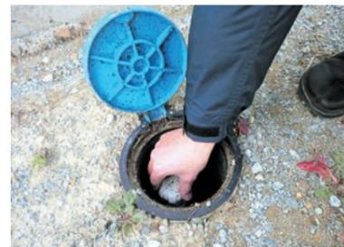
①水抜栓を時計回りに動かして閉めます。
