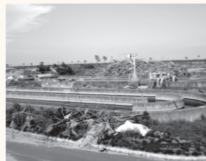
被災した山元浄化センター(花釜区)
