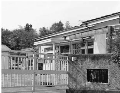
使用不能となった南保育所
