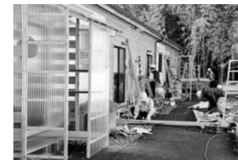
各仮設住宅で急ピッチで進められる寒さ対策工事(中山仮設住宅)
