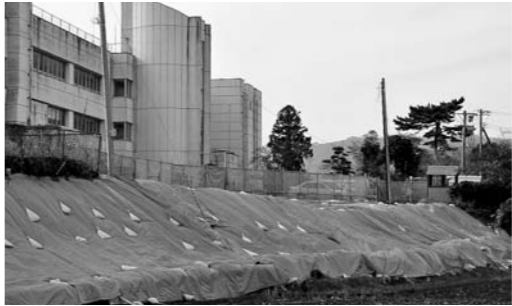
坂元小北側の法面崩壊
