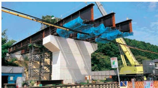
着々と進捗する橋りょう工事
