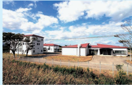
山元浄化センター
