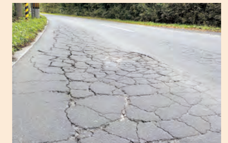
▲町道東街道の路面被害状況
