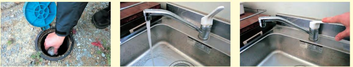
①水抜き栓が完全に止まるまで時計回りに回します。
