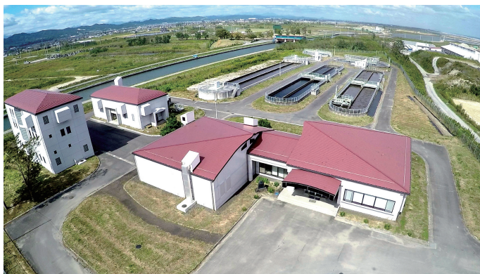
山元浄化センター（復旧後）
