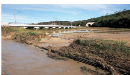
▲10月25日の大雨で破堤した戸花川
