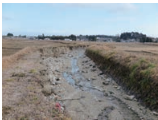
台風19号被害箇所
