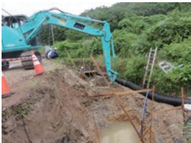
復旧作業の風景
