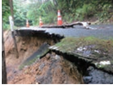
崩壊した道路
