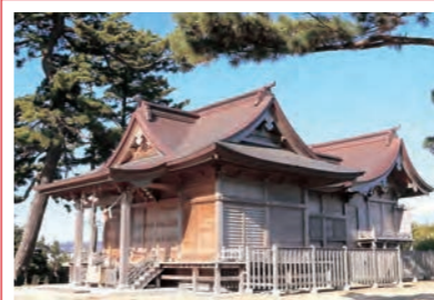
▲平成29年9月に再建された八重垣神社の社殿
