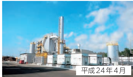
約221万トンの災害廃棄物処理した震災 廃棄物焼却処理施設
