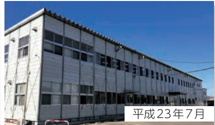
完成したプレハブの役場仮庁舎。業務期間は平成31年4月までの約8年間におよんだ。
