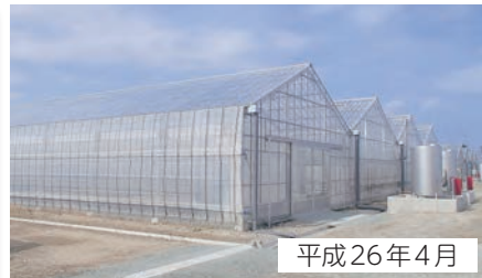
いちごの産地復活に向け、整備された大型鉄骨ハウス
