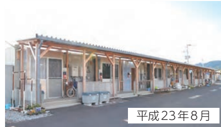
応急仮設住宅は、町内8カ所に1,030戸が整備された
