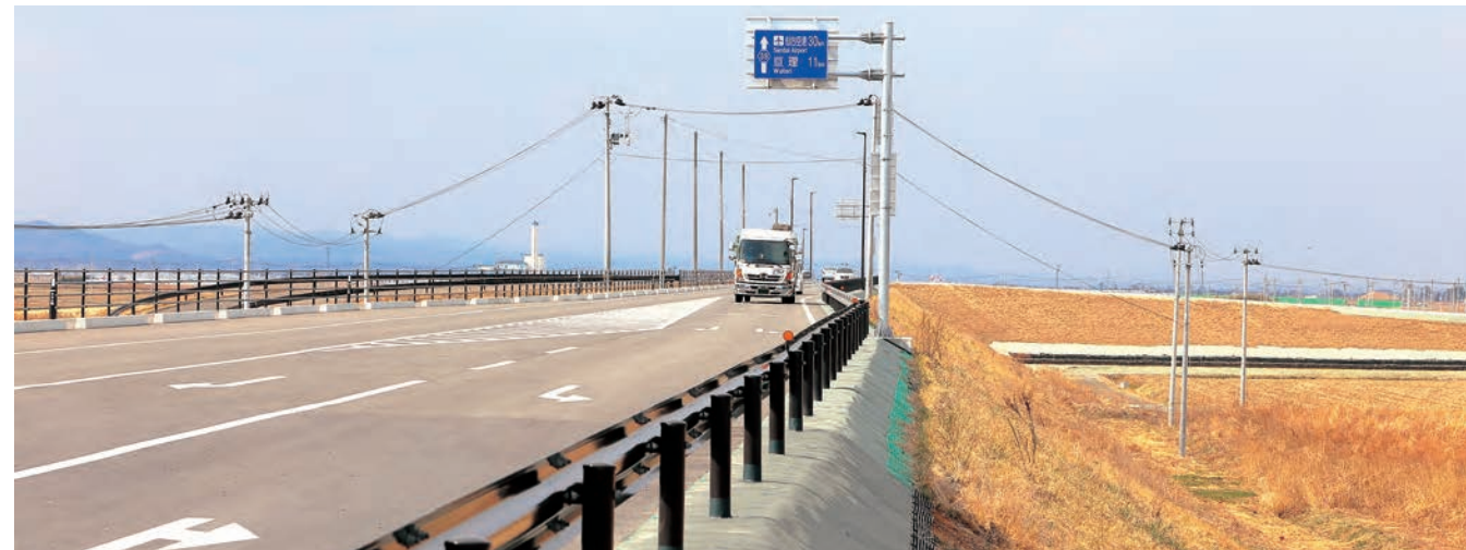
▲全線で開通した県道相馬亘理線。盛土高は2m以上、道路幅は10m以上と、本町の安全と安心を支えます
