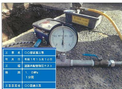
道路内耐圧テスト
