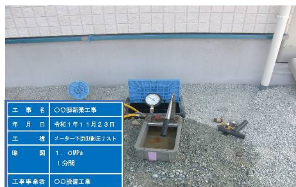
メーター下流側耐圧テスト
