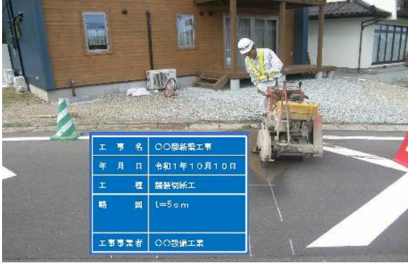
工事着手前（舗装切断工）
