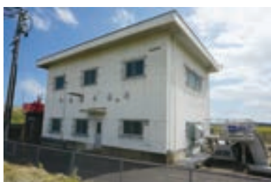
谷地排水機場 (中浜区)
