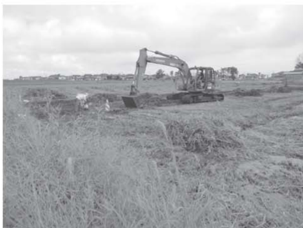
農地復旧除塩工事の様子
