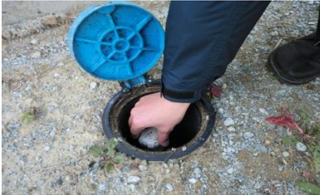
①水抜栓を閉める。**時計回り**に動かすと止まります。
