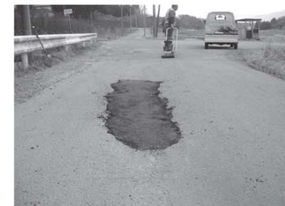
維持補修作業を随時行っています
