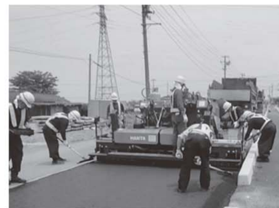
町道復旧工事の様子
