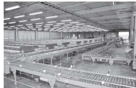
広大な場内には、最新設備が所狭しと並んでいます
