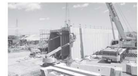
写真② カルバートボックス工事(麓足地内)
