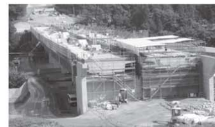
写真① 橋梁工事(久保間地内)
