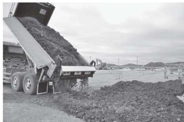
造成地内に次々と運び込まれる「山元町支援の土」。
