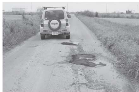
道路パトロールで補修を実施
