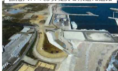
漁港入口の締切堤防と乗越え道路
