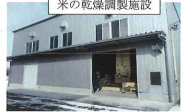
米の乾燥調製施設
