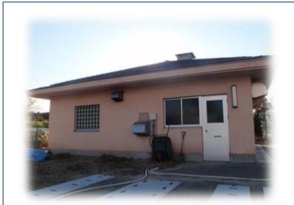
旧坂元農業集落排水施設
