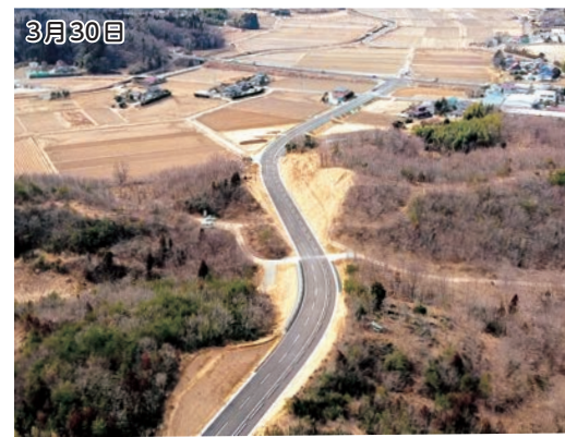
3月30日 東西に延びる町道真庭新浜線が全線開通
