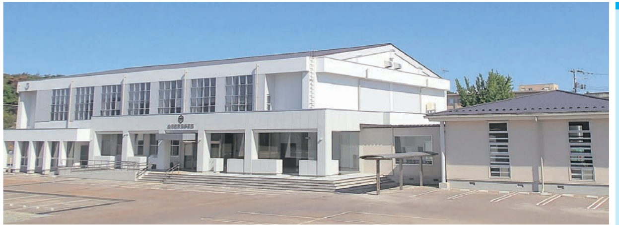
屋上防水や外壁塗装などの改修を施した外観
