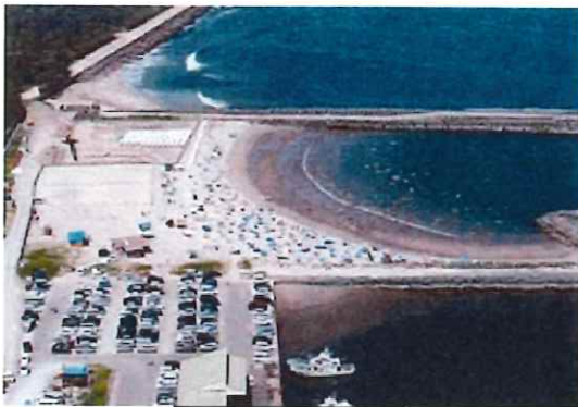
被災前の利用状況
