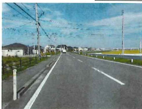
完成①（起点部）
