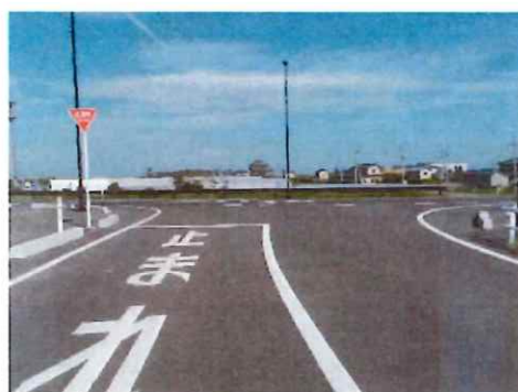
完成④（終点部）
