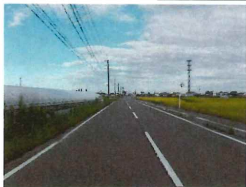
完成①（起点部）
