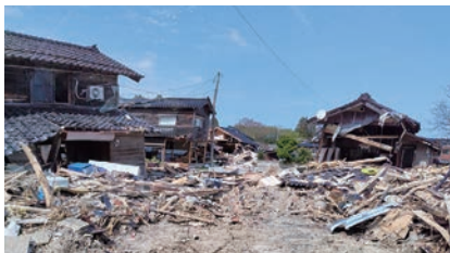
能登町の被害家屋状況
