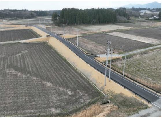
完成後の中浜滝の前線北側から南側を望む (令和6年3月撮影)
