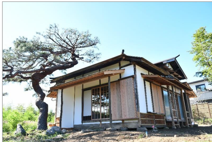
[修復工事が完成した茶室]
