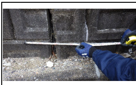
写真5 定点観測2 ブロック積擁壁の目地開き
