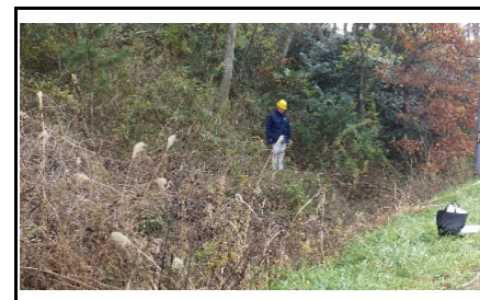
写真16 のり尻の状況 フトンご設置
