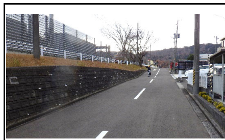
写真6 旧地形の谷筋付近、沈下による擁壁の撓み
