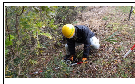
写真15 のり肩の状況 勾配:29°
