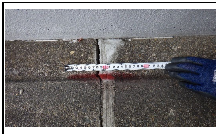
写真6 定点観測2 L型の目地開き
