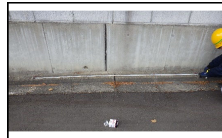
写真4 定点観測1 L型の目地開き
