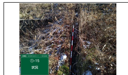
写真⑪ 盛土下端部(縦排水路)
