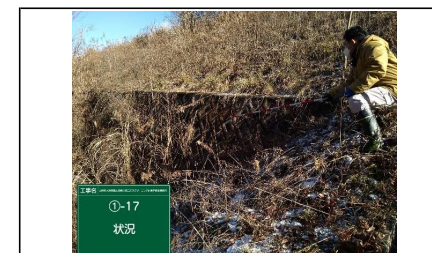
写真⑫ 盛土下端部(ブロック積擁壁)
