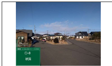
写真① 盛土上端部(道路状況)
