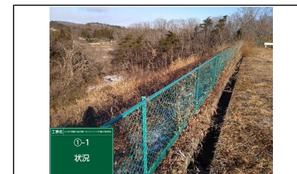
写真⑧ 盛土上端部(排水溝及びフェンス)
