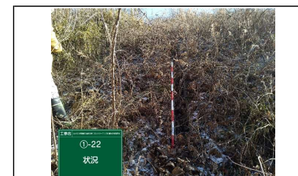
写真⑯ 盛土下端部(縦排水路)
