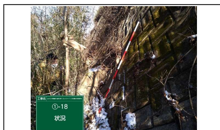
写真⑬ 盛土下端部(ブロック積擁壁の一部にはらみ
