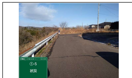
写真⑥ 盛土上端部(道路の亀裂補修跡)
