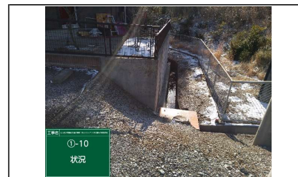
写真③ 盛土上端部(宅地擁壁状況)
