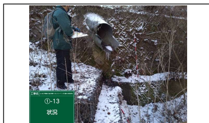
写真⑨ 盛土下端部(排水溝出口及び擁壁)
