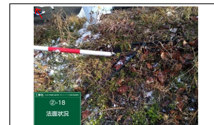
写真⑧ 盛土上端部(法面保護工: ネット)
