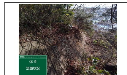
写真⑮ 盛土下端部(ブロック積擁壁)
