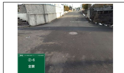
写真⑥ 盛土上端部(道路状況)
