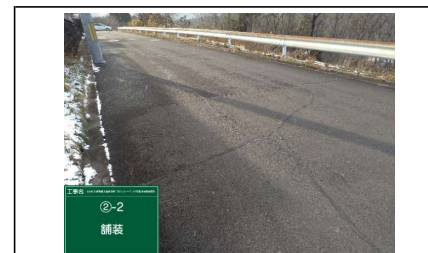
写真③ 盛土上端部(道路の亀裂補修跡)
