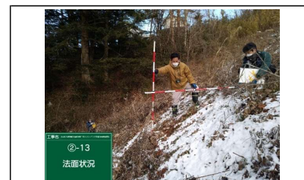
写真⑪ 盛土中間部
