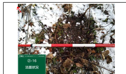
写真⑩ 盛土中間部(法面保護工: ネット)
