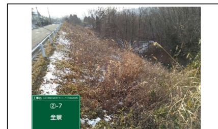
写真⑦ 盛土上端部(法面状況)
