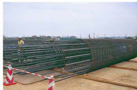
高架橋の柱を支える杭に使われる鉄筋かご
