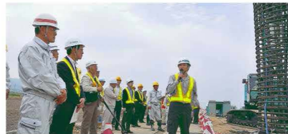
杭打ち込み現場で工事の説明を受ける関係者(齋藤町長【手前】と竹内所長【右隣】)
