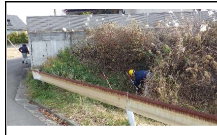
写真15 のり尻付近、のり面勾配:27°(盛土部)
