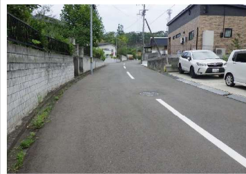
⑥ 路面状況(変状無し)
