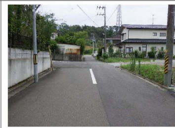
㉔ 路面状況(擁壁に亀裂)
