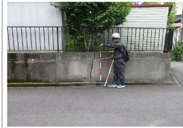
㉖ 宅地擁壁の亀裂
