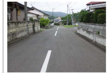
⑤ 路面状況(変状無し)
