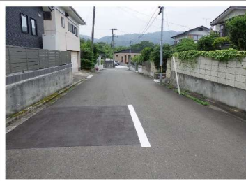
㉒ 路面状況(変状無し)
