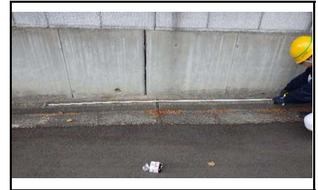
写真4 定点観測1 L型の目地開き
