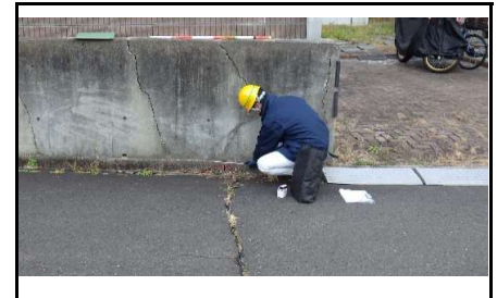
写真12 定点観測4 L型の目地開き
