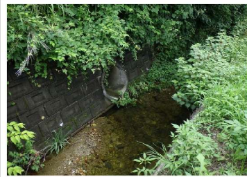
① 盛土末端部(排水管)
