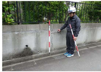
㉗ 宅地擁壁の亀裂
