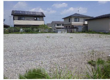
④⑬ 盛土境界付近(若干の沈下)
