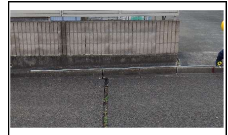
写真12 定点観測4 L型の目地開き
