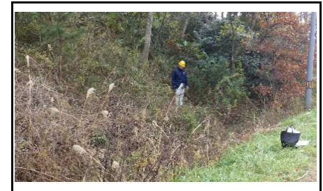
写真16 のり尻の状況 フトンご設置
