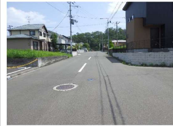
⑭ 路面および擁壁に変状無し
