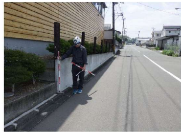
㊿ 擁壁の沈下
