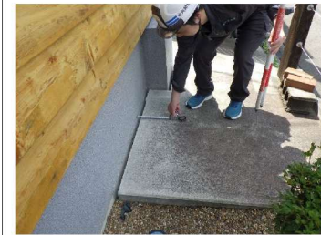
㊿ 土間コンクリートのせり出し(2~3cm) ※道路側+周辺地盤の沈下
