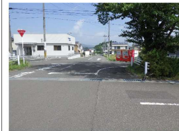
④⑲ 盛土境界付近
