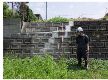
㉓ ブロック積擁壁の目地開き(補修済)
