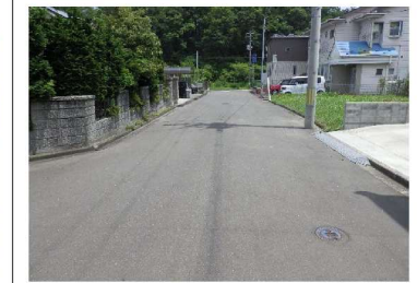
④⑩ 路面に変状無し
