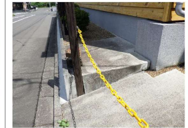
㊿ 土間コンクリートのせり出し(2~3cm) ※道路側+周辺地盤の沈下
