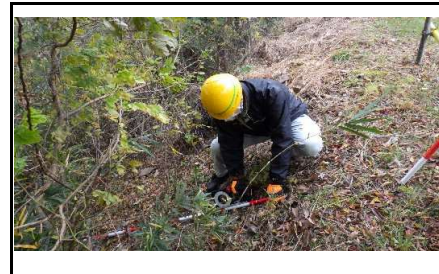
写真15 のり肩の状況 勾配:29°
