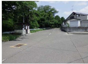
⑫ 路面に変状無し
