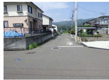
④⑧ 路面および擁壁に変状無し
