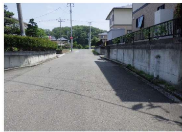
④⑥ 沈下による路面変状+亀裂
