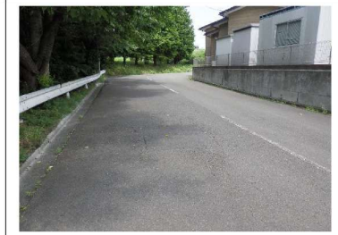
⑤ 路面に変状無し
