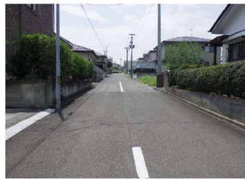
㉖ 沈下による路面変状+亀裂
