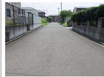
④④ 盛土境界付近(変状無し)
