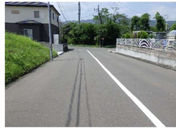
⑬ 路面および擁壁に変状無し
