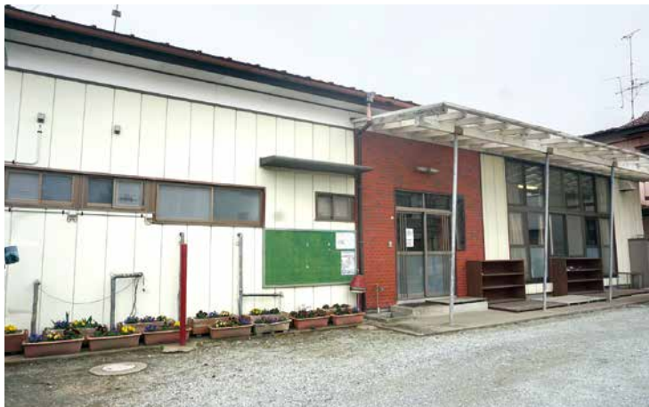
老朽化する町区老人憩いの家
