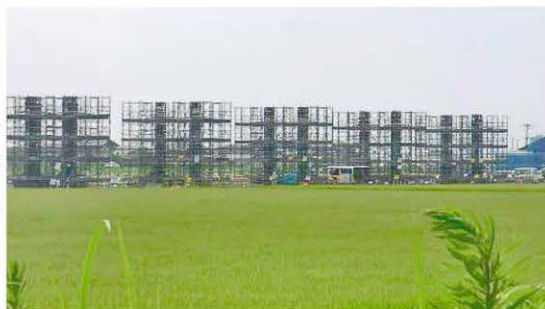
着々と工事が進む高架橋
