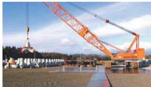
200トンのつりクレーンが16型消波ブロックをつり上げています。
