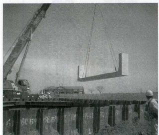
高浦橋の復旧工事 (ボックスカルバートを設置しています)
