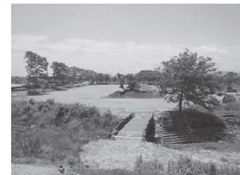
年度内完了に向け復旧工事が急ピッチで進む牛橋公園
