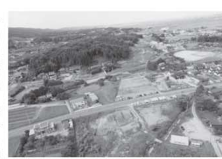
発掘現場と高速道路(山寺区内)
