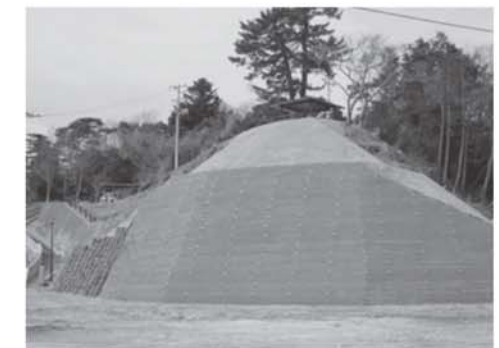
復旧工事が完了した磯崎山公園
