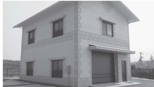
復旧した汚泥脱水設備棟
