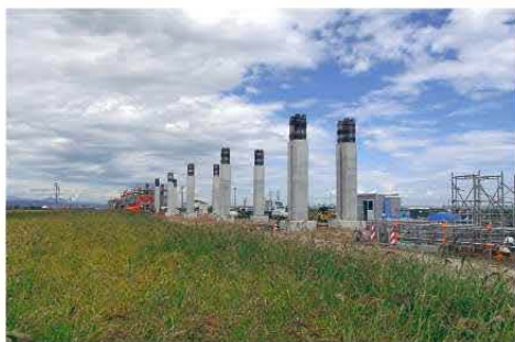
着々と工事が進む高架橋
