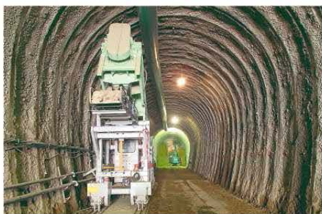
トンネル工事の様子
