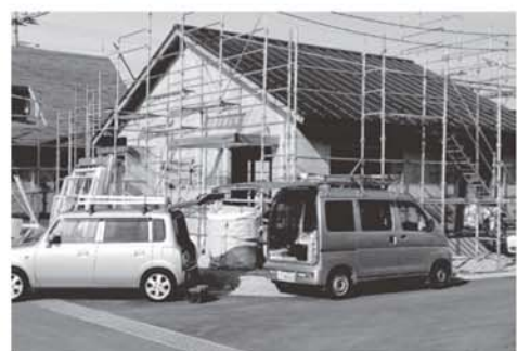
新山下駅周辺地区 第2期公営住宅工事中(10月30日)
