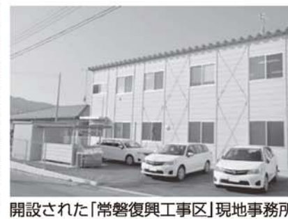
開設された「常磐復興工事区」現地事務所
