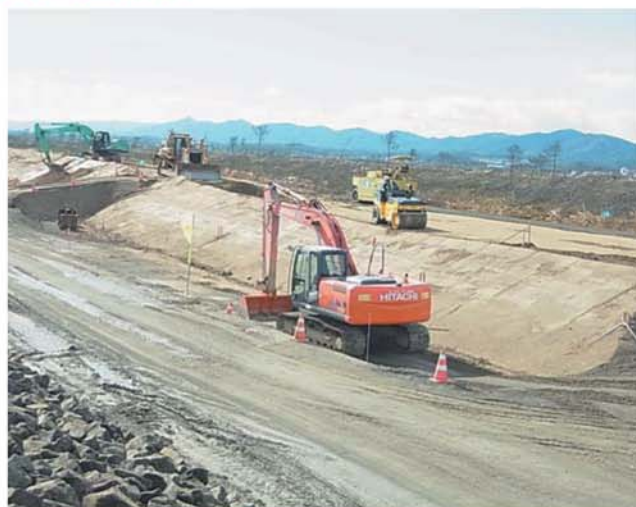
施工中(平成24年11月)
