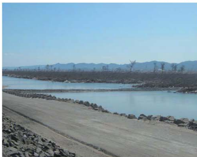
施工前(平成24年4月)
