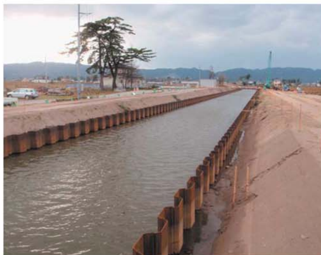
工事中の落し堀排水路
