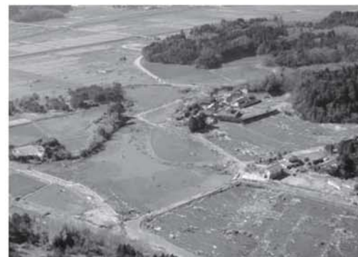
南方向と東方向からの津波に襲われた木ノ岡周辺の上空写真 (H23.3.19撮影)
