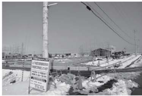
順調に進捗する山下地区災害公営住宅工事
